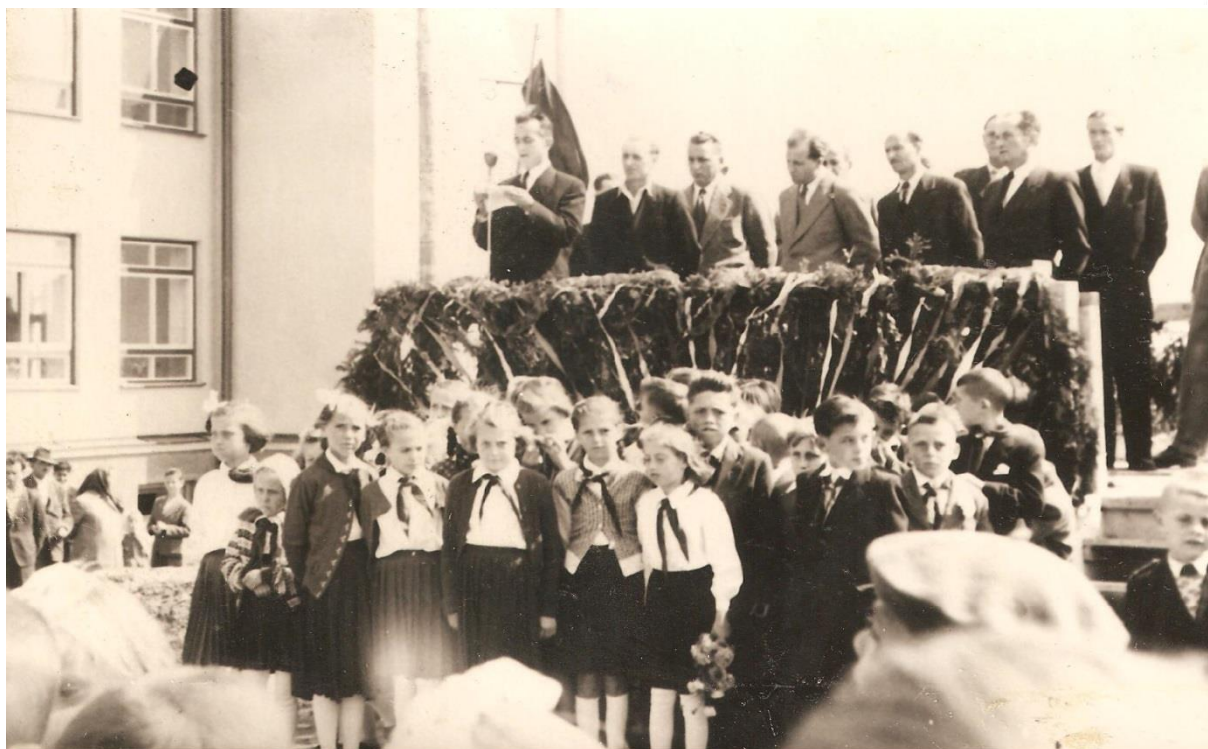
fotografia zo slávnostného otvorenia novej budovy školy, šk. rok 1957/58
